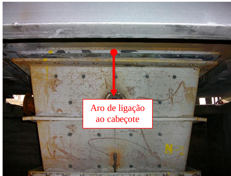
Fig. 5.3 – Aro de ligação ao cabeçote
