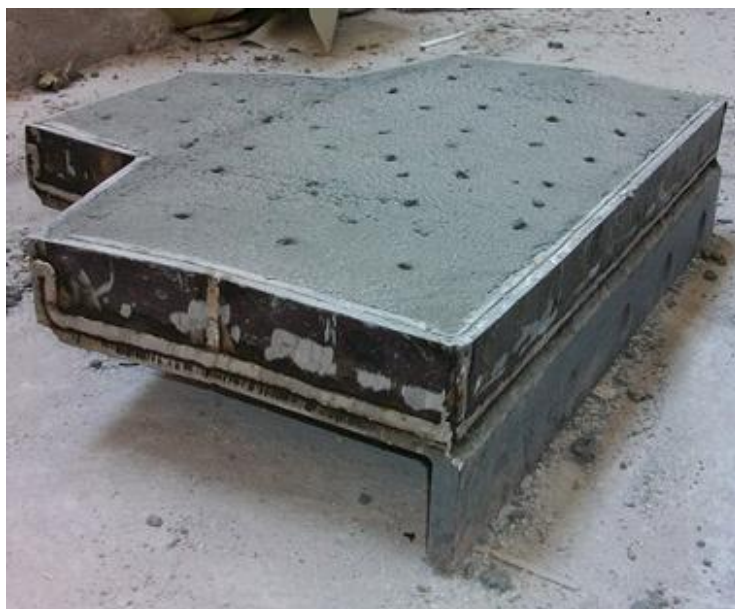
Fig. 6.10 – Protecção dos veios dos rolos revestida a betão
