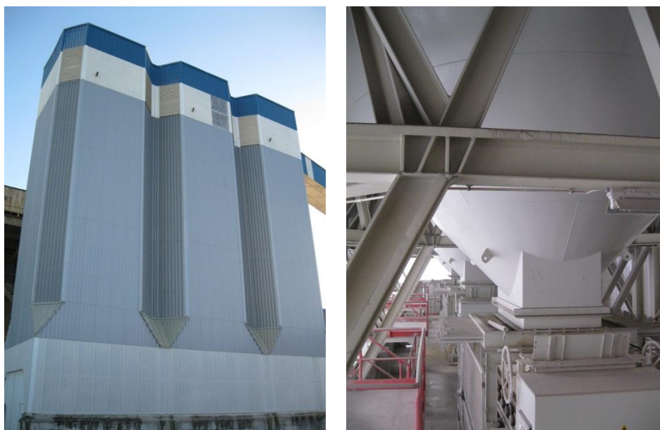
Fig. 4.6 – Silos de armazenamento de calcário branco: exterior (à esquerda) e base (à direita)
