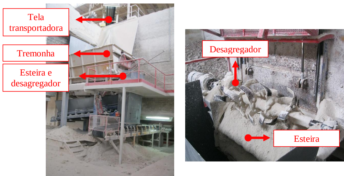
Fig. 4.8 – Preparação das natas de mármore (à esquerda) e esteira e desagregador (à direita)
