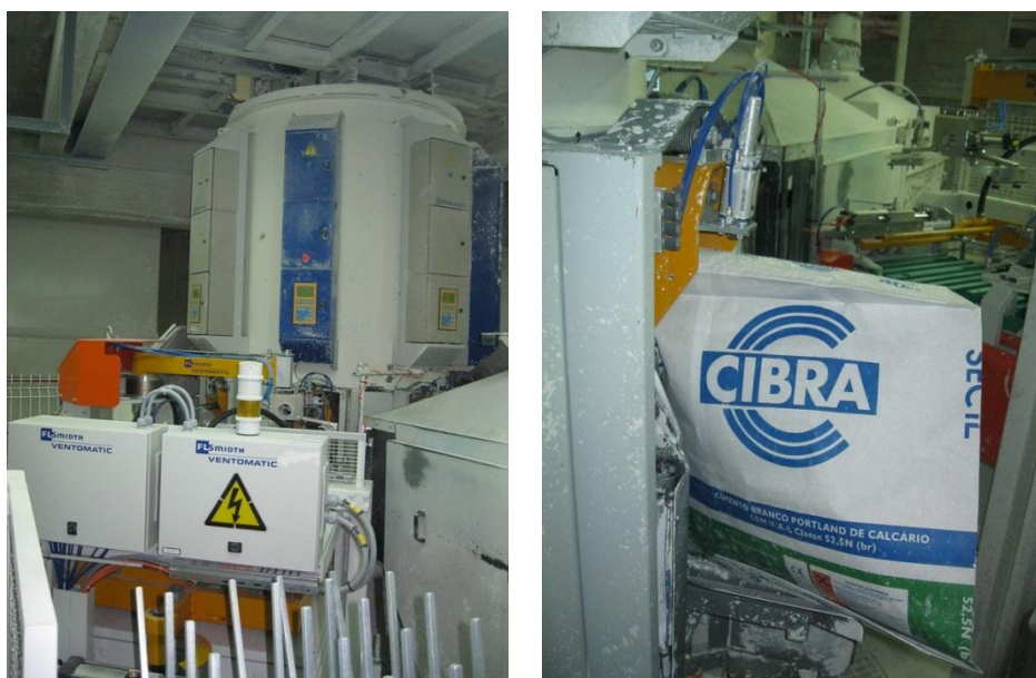
Fig. 4.31 – Ensacadeira de cimento branco (à esquerda) e bica de enchimento (à direita)
