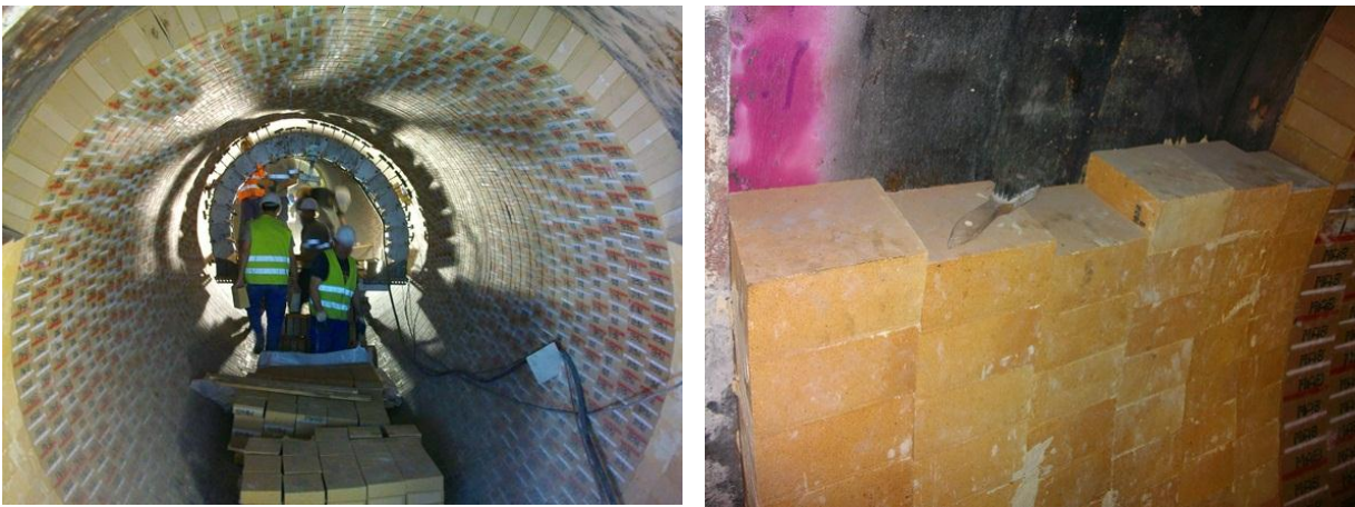
Fig. 4.24 – Aplicação de tijolo refractário no interior do forno
