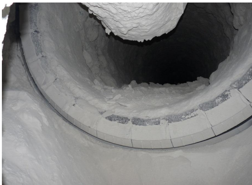
Fig. 5.10 – Incrustações e grânulos no interior do forno de cimento branco
