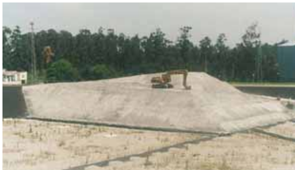
Figura 57 – Sistema de babetes instalado num aterro (Ambirumo)
