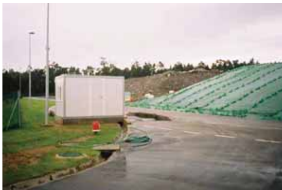
Figura 60 – Exemplo de colocação de telas temporárias (Ambirumo)
