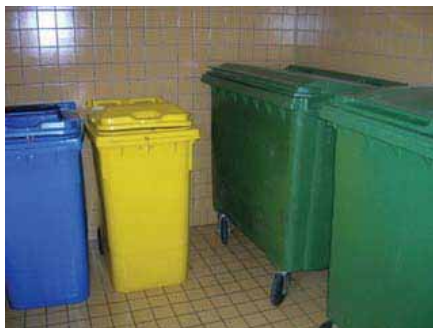
Figura 4 – Exemplo de modelos de contentores utilizados para a recolha selectiva porta-a-porta de papel/cartão (azul) e embalagens (amarelo) em compartimentos de resíduos (concelho de Matosinhos) (Ambirumo)
