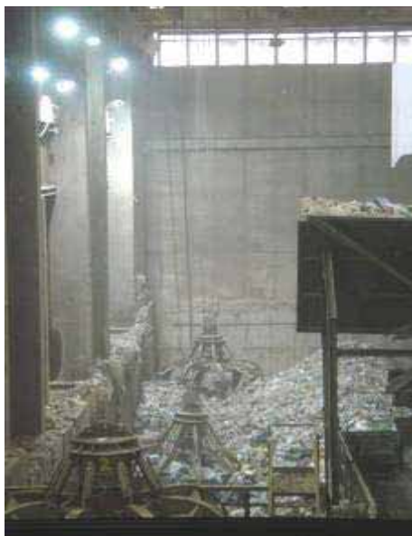
Figura 45 – Fossa de resíduos (Ambirumo)
